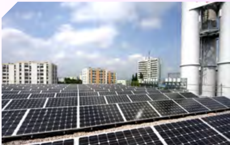
Chaufferie de Vandoeuvre - Métropole du Grand Nancy
