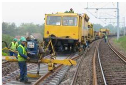
Longs Rails soudés sur traverses béton
