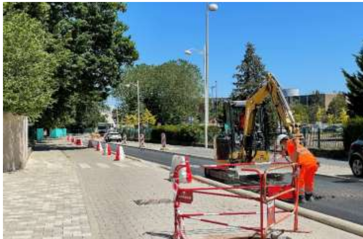
Figure 27 – Travaux dans le cadre du P2M (source Métropole du Grand Nancy)
