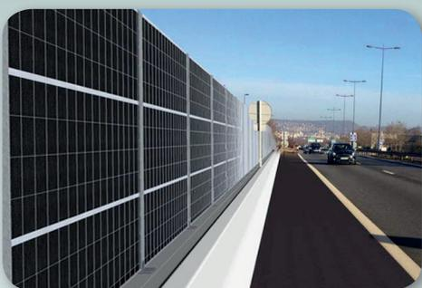
Initiés dans le cadre du plan de relance, et programmés en 2022, les travaux de réalisation de l'écran acoustique font suite au renforcement du mur en terre armée réalisé en 2021.
