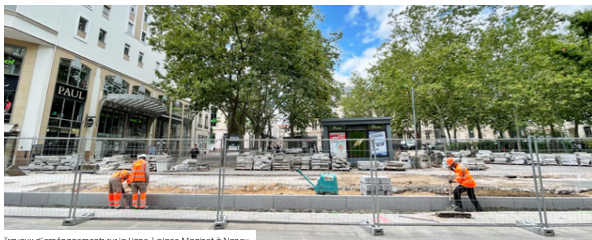
Travaux d'aménagements sur la Ligne 1 place Maginot à Nancy
