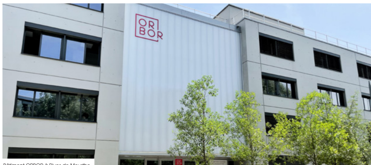
Bâtiment ORBOR à Rives de Meurthe
