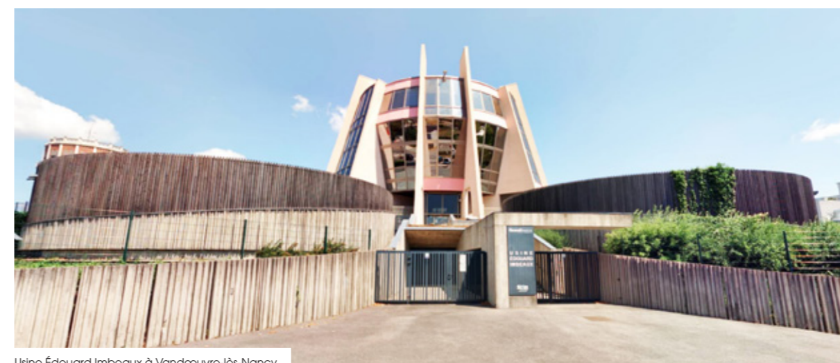
Usine Édouard Imbeaux à Vandœuvre-lès-Nancy
