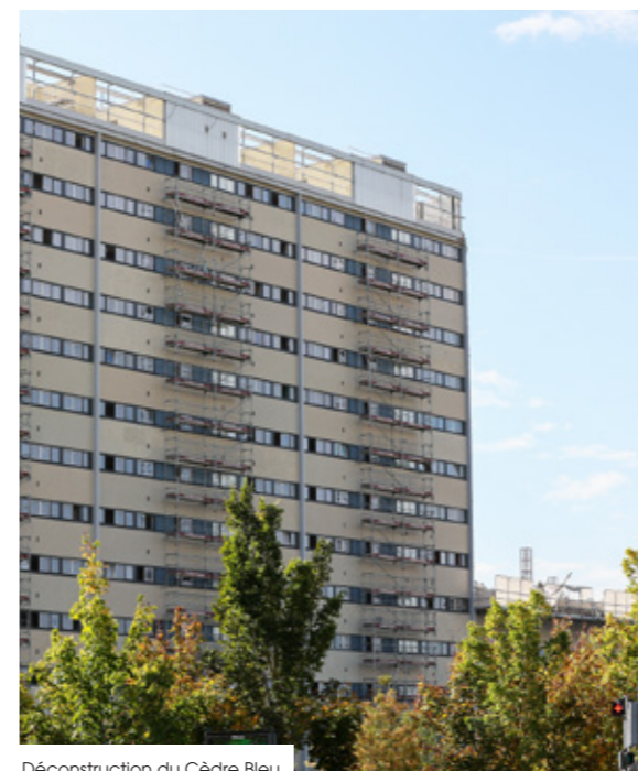
Démolition du Cèdre Bleu
